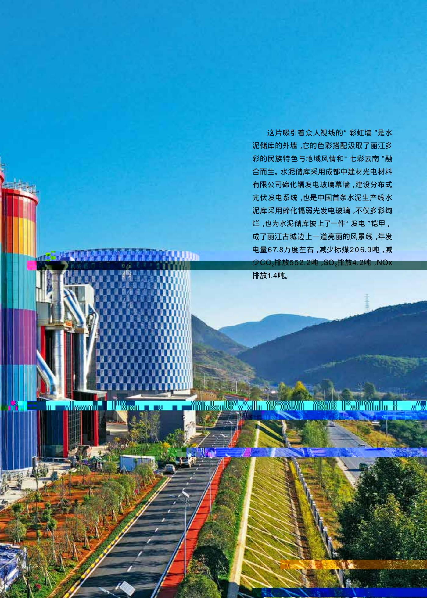
这片吸引着众人视线的“彩虹墙”是水泥储库的外墙，它的色彩搭配汲取了丽江多彩的民族特色与地域风情和“七彩云南”融合而生。水泥储库采用成都中建材光电材料有限公司碲化镉发电玻璃幕墙，建设分布式光伏发电系统，也是中国首条水泥生产线水泥库采用碲化镉弱光发电玻璃，不仅多彩绚烂，也为水泥储库披上了一件“发电”铠甲，成了丽江古城边上一道亮丽的风景线，年发电量67.8万度左右，减少标煤206.9吨，减少CO<sub>2</sub>排放552.2吨，SO<sub>2</sub>排放4.2吨，NO<sub>x</sub>排放1.4吨。
