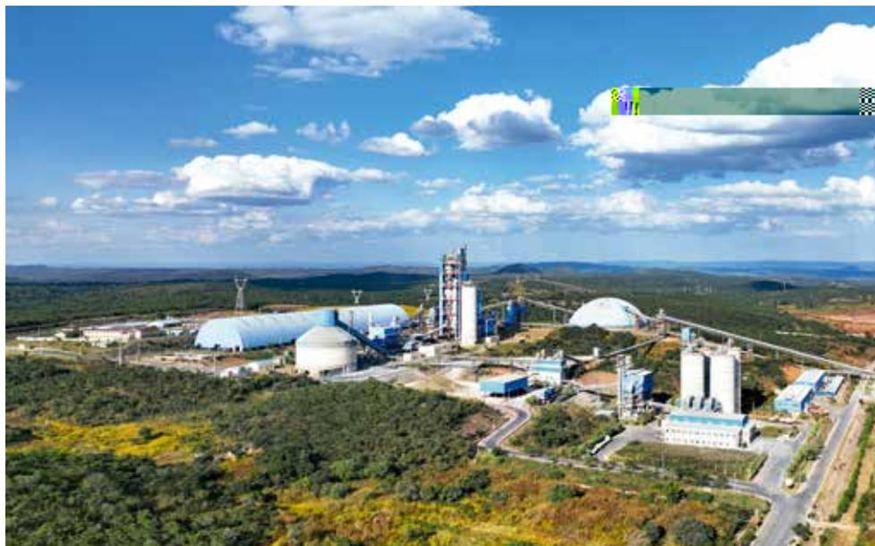
熟料减碳240kg,碳减排28%,每年可减少二氧化碳排放16.3万吨,预计每年产生1000万欧元以上的经济效益,为保护当地生态环境和推进绿色转型贡献了重要力量。波兰拉豪MAL01项目,是豪瑞集团位于欧洲的最大在建项目。项目范围包括从原料处理至熟料输送、替代燃料处理及计量输送,是世界首条采用90%替代燃料的熟料生产线同时配套国产化纯低温余热发电并实现一键启停等智能化工程。该项目投产后年产熟料115万吨。2023年该项目入选了
